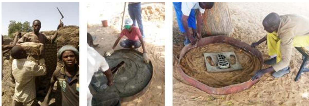
Figure 11 - Aperçu des maçons
